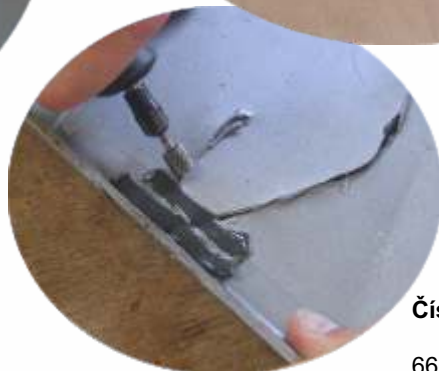
Příprava švu svařování dvouhranným škrabákem.
