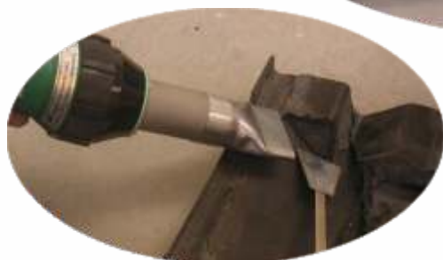
Beznámahné odstraňování izolační rohože z PU.
