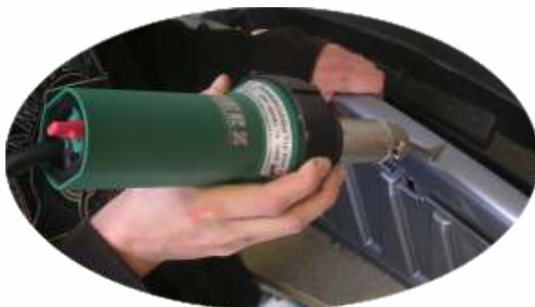
Stehování trhliny před svařením nárazní plochy.
